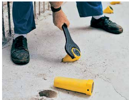
Fremløbskoblingen afmonteres med en fastnøgle SW 70.
