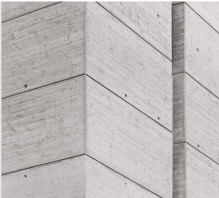
En eksemplarisk synlig betonoverflade med ru, vandret bræddestruktur.
