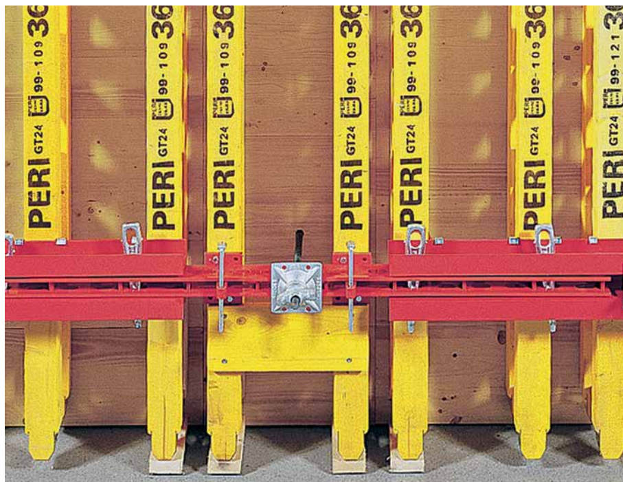
Trinløse tilpasninger med VARIO kobling VKZ.
