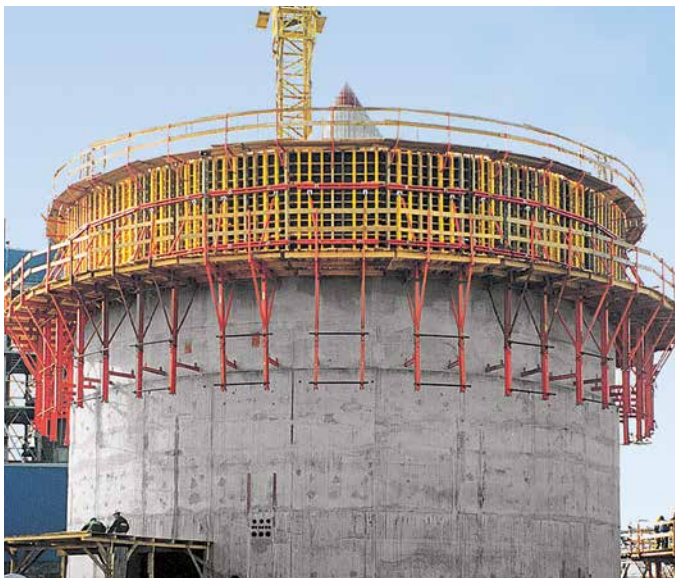
VARIO GT 24 til opførelsen af en tank. Træudligninger mellem dragere og stålriger danner den runde form.
