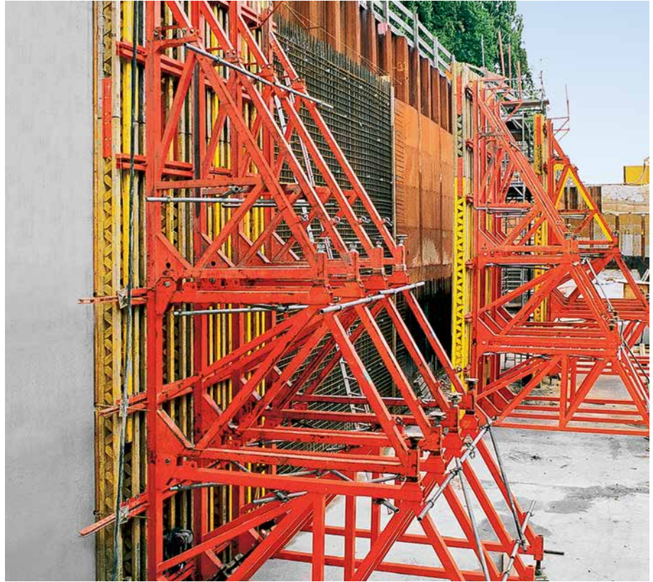
Maks. støbehøjde på 8,75 m, støttebuk-AO, A, B, og C med vægforskalling VARIO GT 24.
