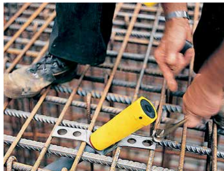
Forankringen monteres nemt på armeringen med tråd og tang.
