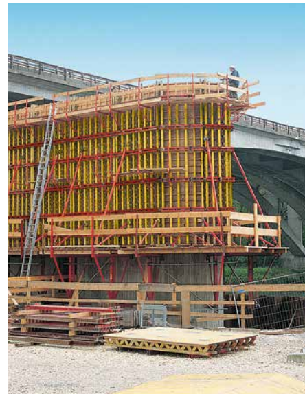
Bropiller på flodbredden forskallet med VARIO GT 24 på PERI klatrekonsol KG 240. De spidse og buede ender blev forskallet med VARIO standarddele og forskallingsbrædder.
