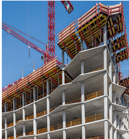
Dækborde med GT 24 drager og stålriger kan designes og samles, så de passer til de projektspecifikke geometrier. Dækbordet flyttes hurtigt og sikkert med en kranaffel til næste opstilling.
