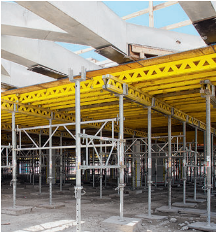
MULTIFLEX dækforskalling – udført med GT 24 forskallingsdrager – bærer her et gitter af bjælker i synlig beton, der senere skal bære et element-dæk.
