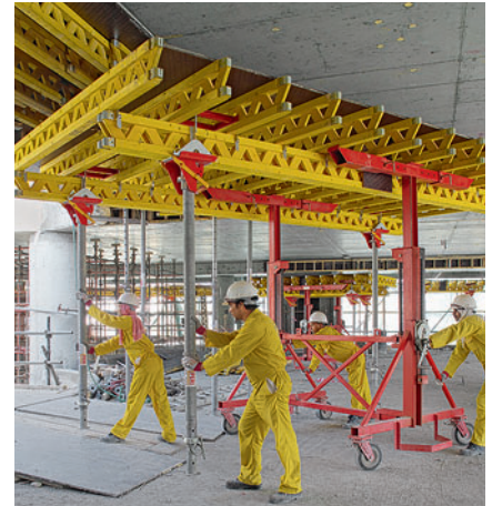
Især ved store dæktykkelser og høje laster kan dækborde udføres med den stærke GT 24 forskallingsdrager.
