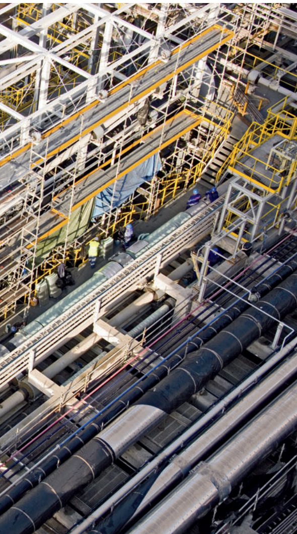
Arbejdspladser til installations- og vedligeholdelsesarbejde, monteres hurtigt med PERI UP. Dæk monteres kun der, hvor de rent faktisk skal bruges.
