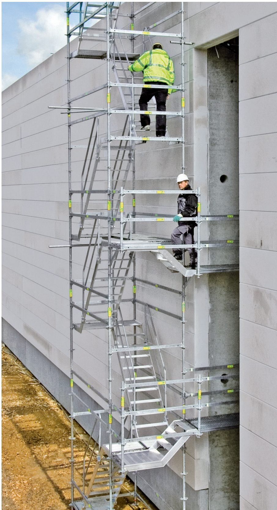
Højdetilpasningerne til bygningsåbninger bygges uafhængig af etagehøjde.
