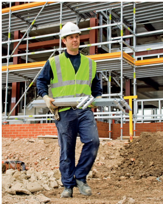
UH-horisontalens ringe bredde muliggør transport af op til 4 horisontaler for montøren på én gang.
