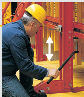
Vertikalindstilling af formen ved VARIO GT 24 med Justeringsenhet CB
