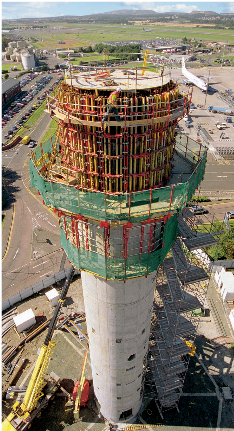
Kontrolltårn i lufthavn 46 m højt, Ø 6,85 m. Med PERI RUND FLEX og CB 240 Konsol.
