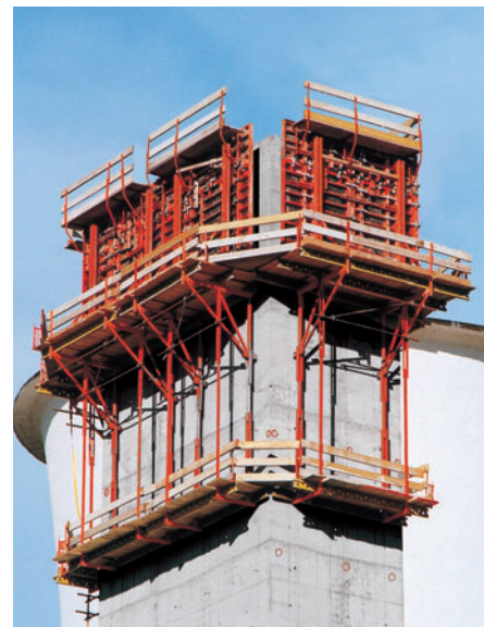
Kontorbygning CB 240 med finish platform og TRIO.
