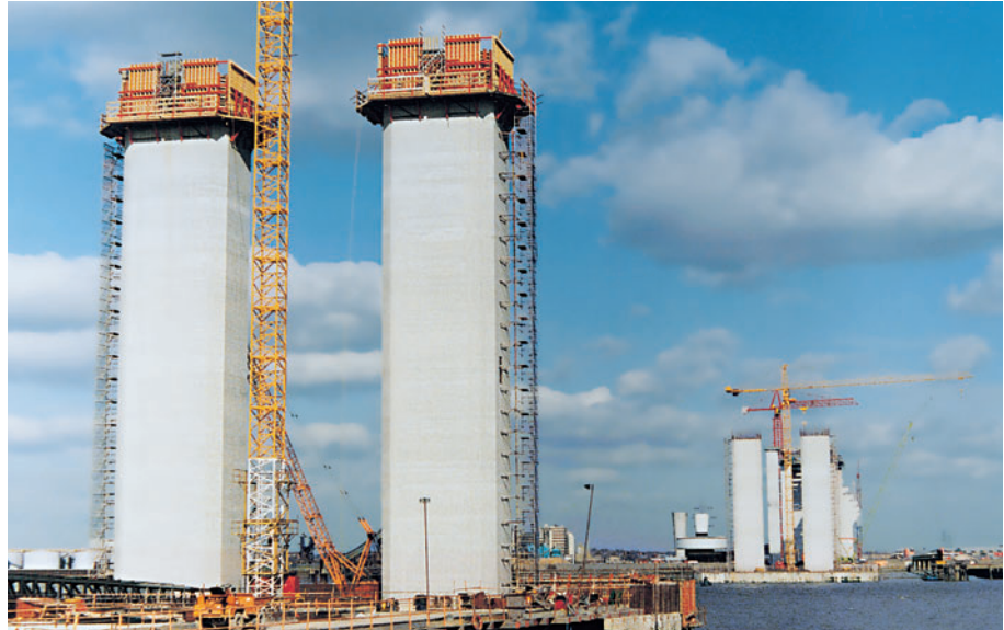
CB 240 med VARIO GT 24 til støbning af bropiller.
