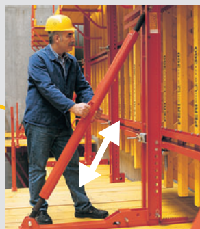
Præcis hældningsindstilling med spindel CB 164 – 224
