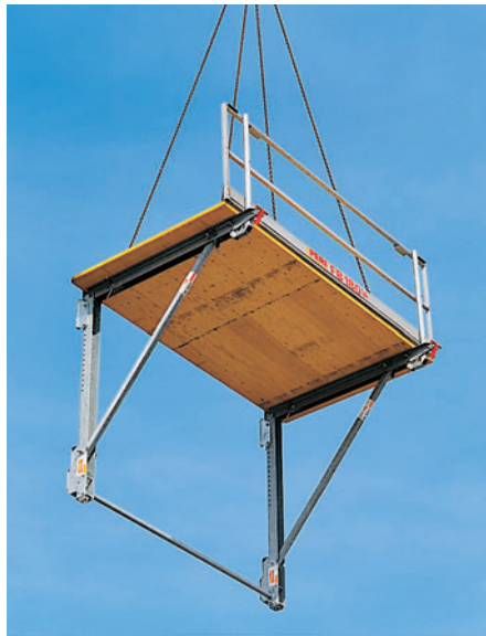
Fastgør 4-slingskæden i kranøjerne og løft op.
