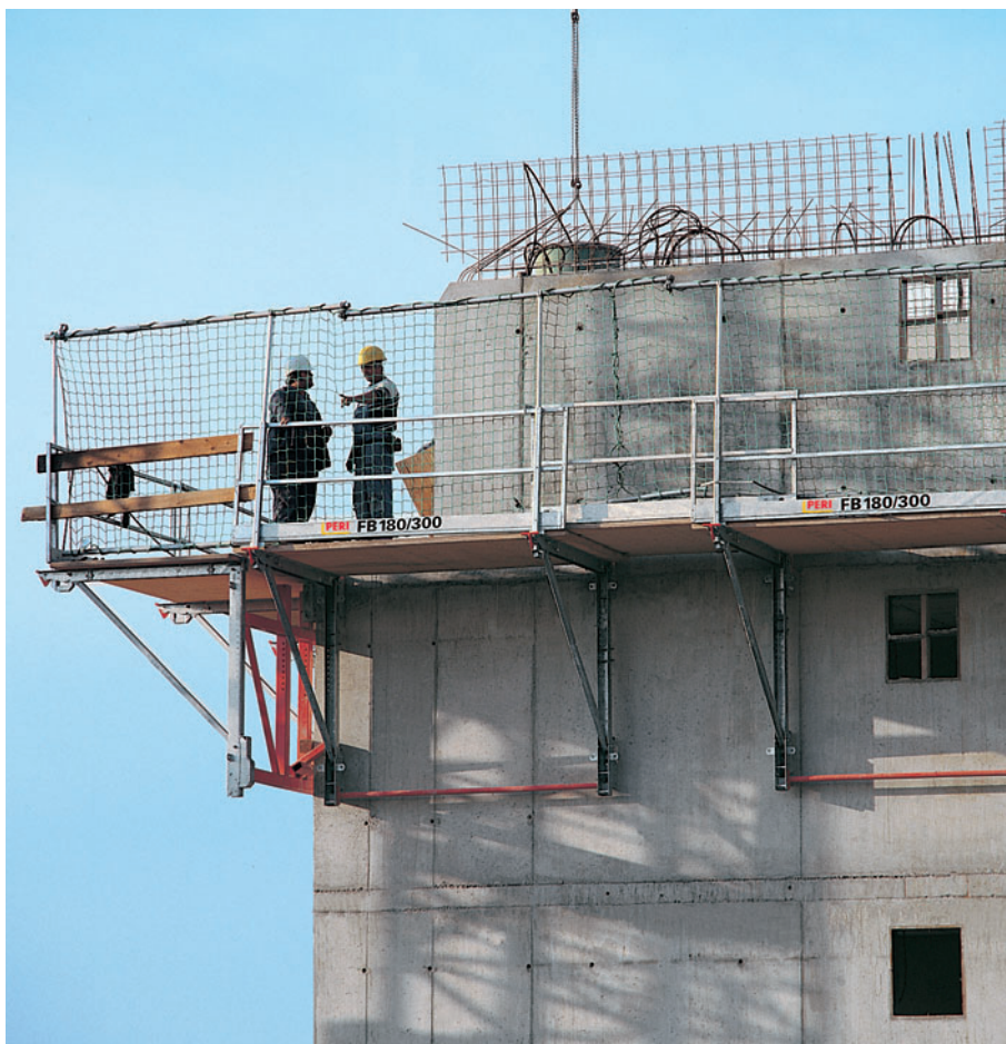
Foldeplatform FB 180-3 som beskyttelsesplatform ved tagudhæng.
