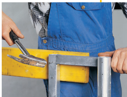
Sømhuller i gelænderrammen gør det nemt at fastgøre rækværk.
