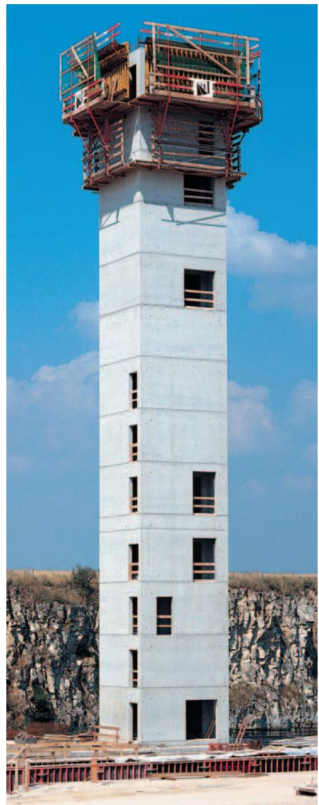
43,50 m högt torn med synliga betongytor i brädstruktur för en industrianolägning.
