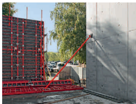
Regelbundna elementfogar och forntagshål på synliga väggtytor. Varuhuset Outlet-Center, Metzingen
