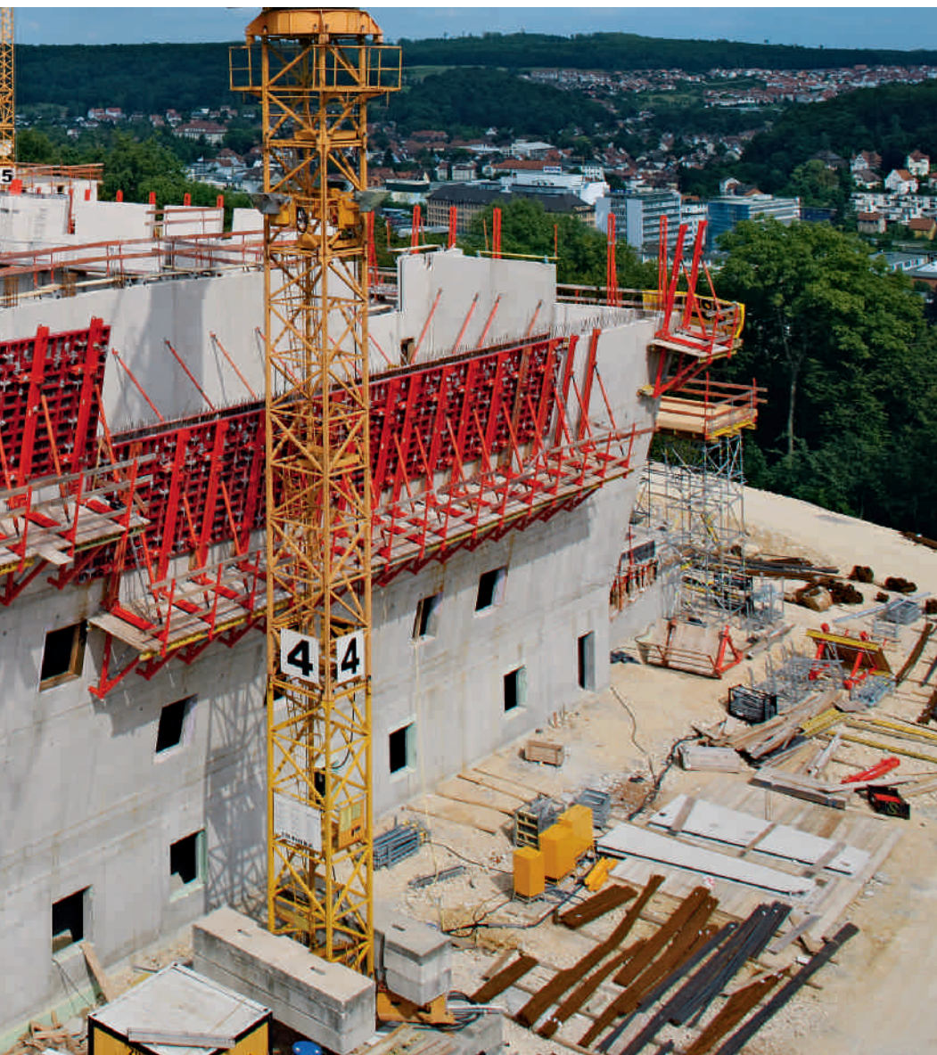
MAXIMO i klätterfunktion på Fasadbrygga FB 180. Siemens Logistikcentrum, Frankfurt
