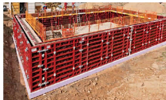
Kort byggtid – hög säkerhet. MAXIMO och PROKIT sidoskyddsgaller på gjutkonsoler. Villakällare, Weißenhorn
